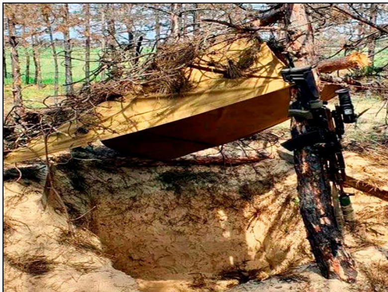
Рис. 6. Индивидуальный окоп с накидкой сверху, замаскированной хвойными ветками из окружающего леса
